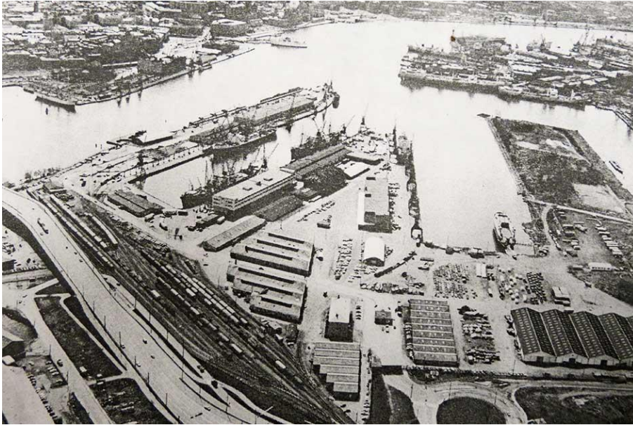
Flygfotografi som visar den mångfald av byggnader som tidigare trängts på pirerna samt hur central bangården och järnvägen var för Frihamnen. Bild från Göteborgs industrihistoriska museums arkiv.
