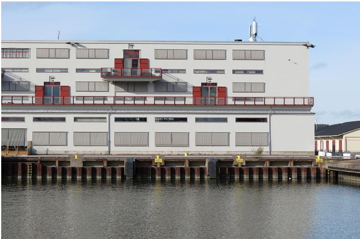
Kajkanter och spår för portalkranar på pirerna i Frihamnen. Ovan till vänster skymtar Kajskjul 113, ovan till höger förvaltningsbyggnaden. Byggnaden ovan är Kajskjul 107. Foto Ida Dicksson 2020.
