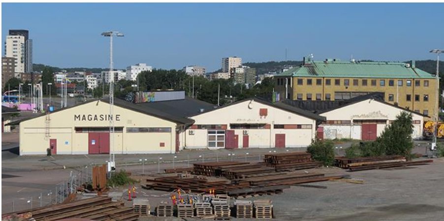
Vänster: Magasin E sett från Götaälvsbron med sydöstra gaveln. Foto Ida Dicksson 2020.
